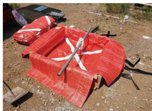
①型枠にD・BOXをセット 規定の型枠にD・BOXをセットします。
