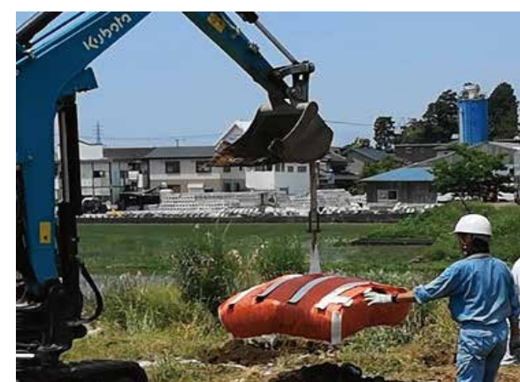
④クレーンで吊り上げ設置 クレーンで吊り上げることで、トラスバンドが袋の張力に加え中詰材料に強力な圧縮力をかけて固化させます。
