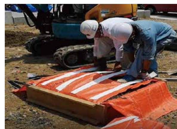
③マジックテープで固定 マジックテープで固定し、中詰材料を袋で包み込みます。
