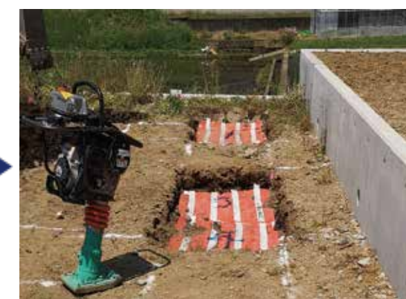
⑤締めめ機で転圧 上から締めめ機でさらに転圧を加え強化させます。
