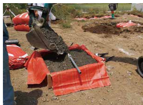
②中詰材料を投入 規定の中詰材料をしっかり投入します。
